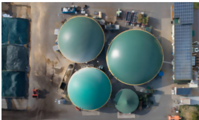
Le Cabinet Fact propose des assurances pour les installations industrielles.
